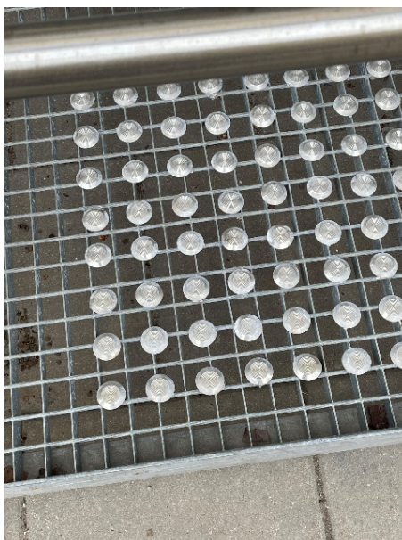
6 pav. Taktilinių paviršių tvirtinimas prie plieninių grotelių
